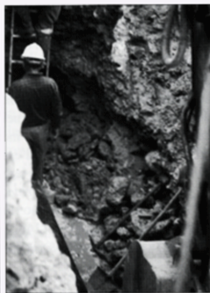
Fig. 4b - Particolare della foto precedente. Scavo profondo sotto la torre con argine di massi e breccie. (Foto dell'autore)
