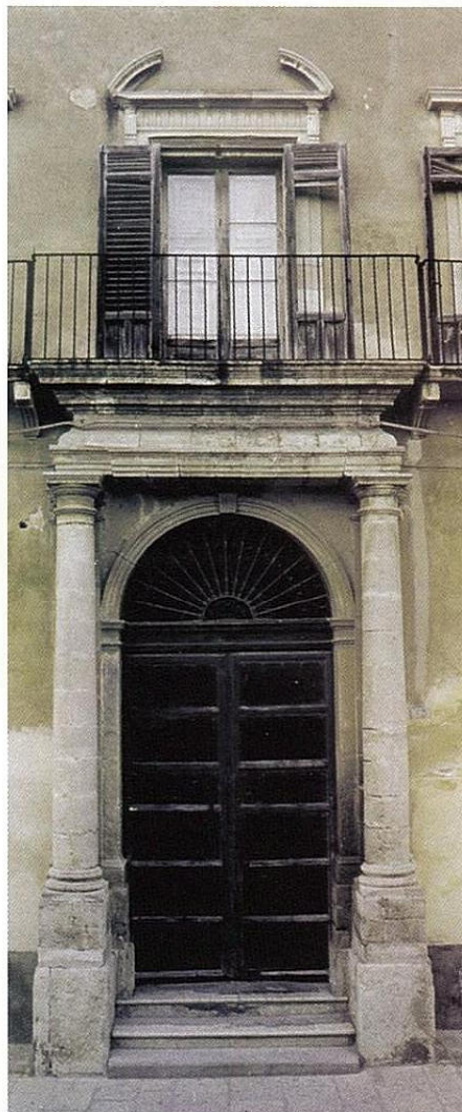
Particolare del prospetto.
