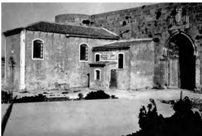
Fig. 4. Siracusa. Chiesa di San Giacomo al Castello, 1761 (da G. Agnello, L’architettura sveva in Sicilia , Roma 1935, p. 49).
