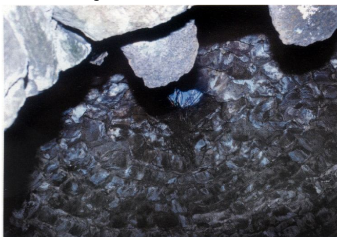
Il tetto visto dall'interno con il buco dal quale venivano buttate le palle di neve .
