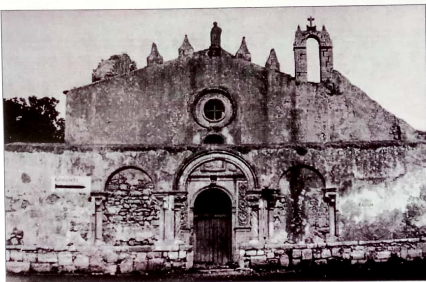
G. Agnello, Architettura Bizantino-Normanna. La Basilica dei SS. Giovanni e Marziano in Siracusa , in "Bollettino d'Arte del Ministero della P.I.", Luglio 1929. Facciata della Chiesa dei SS. Giovanni e Marziano di Siracusa.
