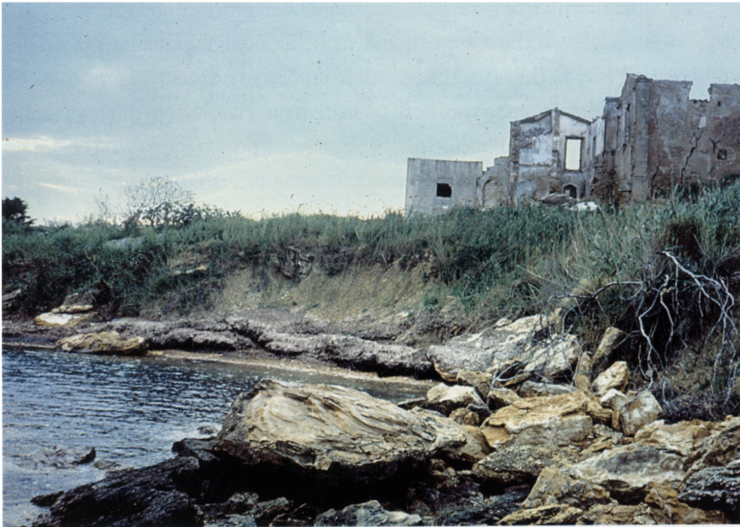
(fig. 3a) La Tonnara di Terrauzza aggredita dall'erosione accelerata (su argille) del mare.
