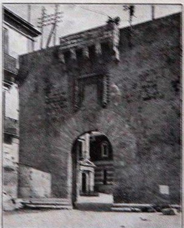
Porta a Minerva, edificio d'architettonica celsissima (sec. XV).
