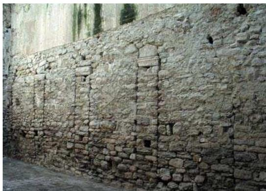
Fig. 54. Parete settentrionale della navata con le aperture più antiche, in seguito murate, definite da pilastri con capitelli rettangolari (foto E. Canzonieri).
