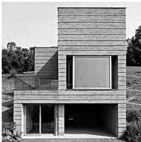
Casa Rauch a Schlins, in Austria (2008). A sinistra, particolare del muro realizzato in terra compressa stratificata.
