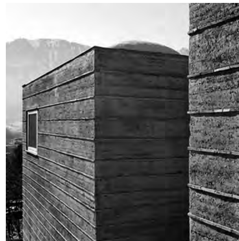
Casa Rauch a Schlins, in Austria (2008). A sinistra, particolare del muro realizzato in terra compressa stratificata.
