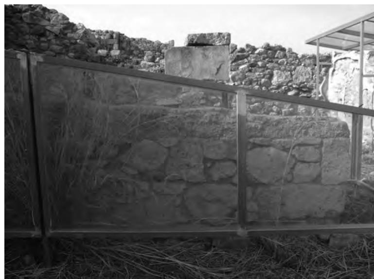
Solunto: a destra, copertina in laterizi sopra tratto di muratura in adobe su stereobate lapideo; a sinistra, teca "protettiva" (2007).
