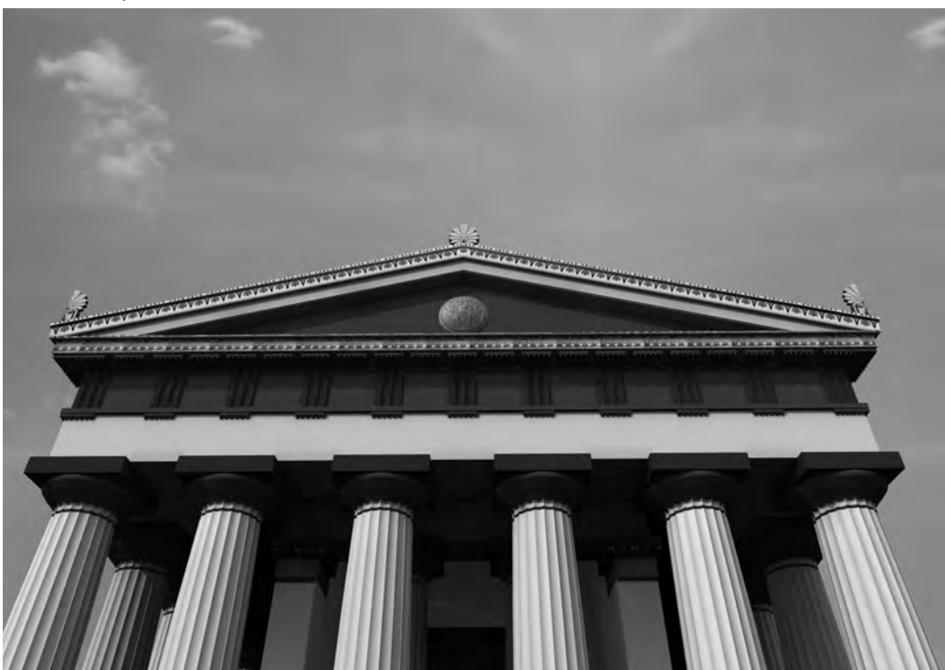
Particolare del frontone Est.
