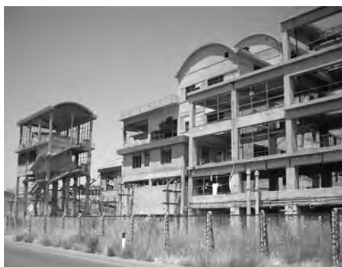
L'impianto a doppio scambio.
