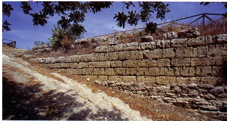
Tratto di mura, lato Sud.
