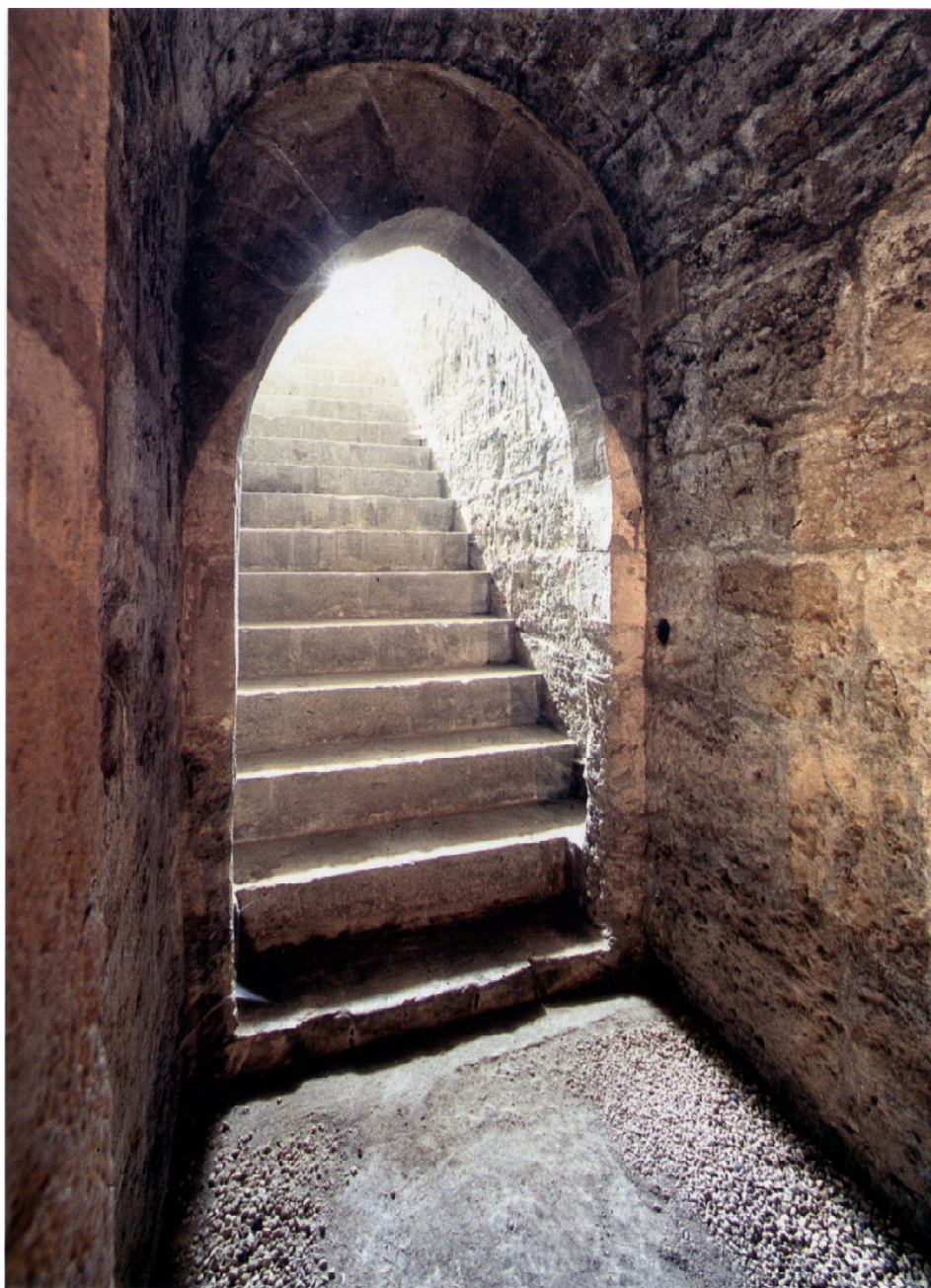
Scala di servizio all'ambiente sotterraneo.
