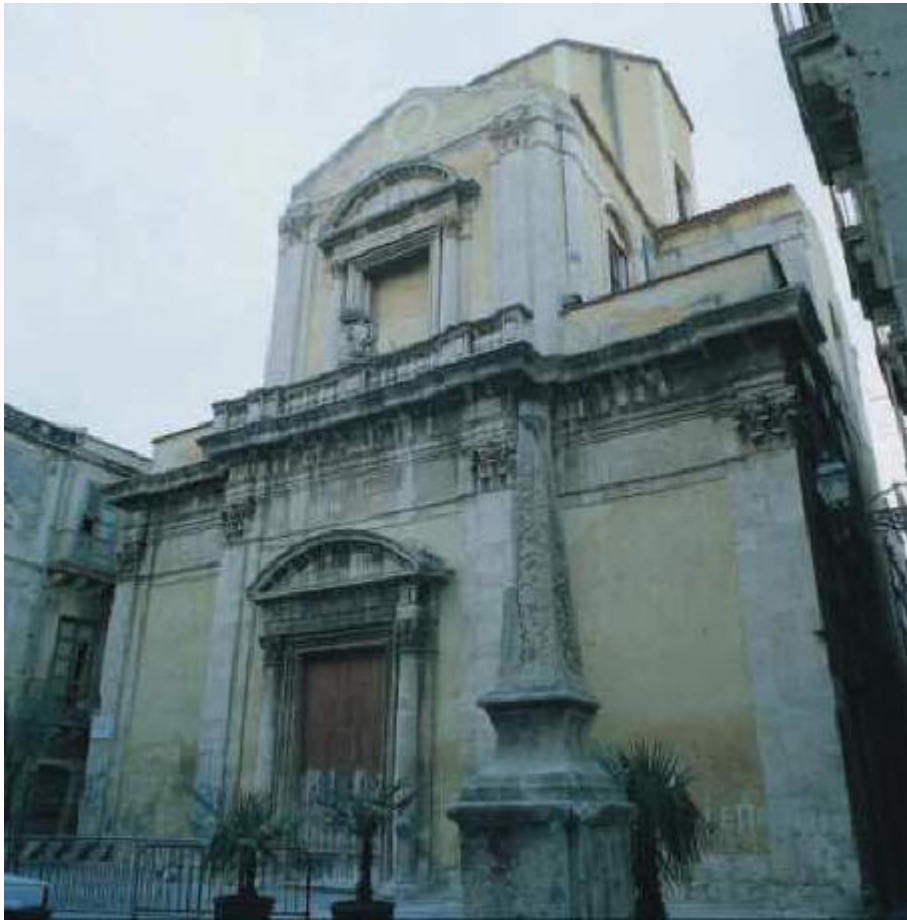
Chiesa di San Filippo Apostolo: Prospetto
