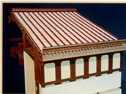
2. Plastico della struttura lignea del tetto con la copertura di tegole ed il sistema di *sima* e cassetta
