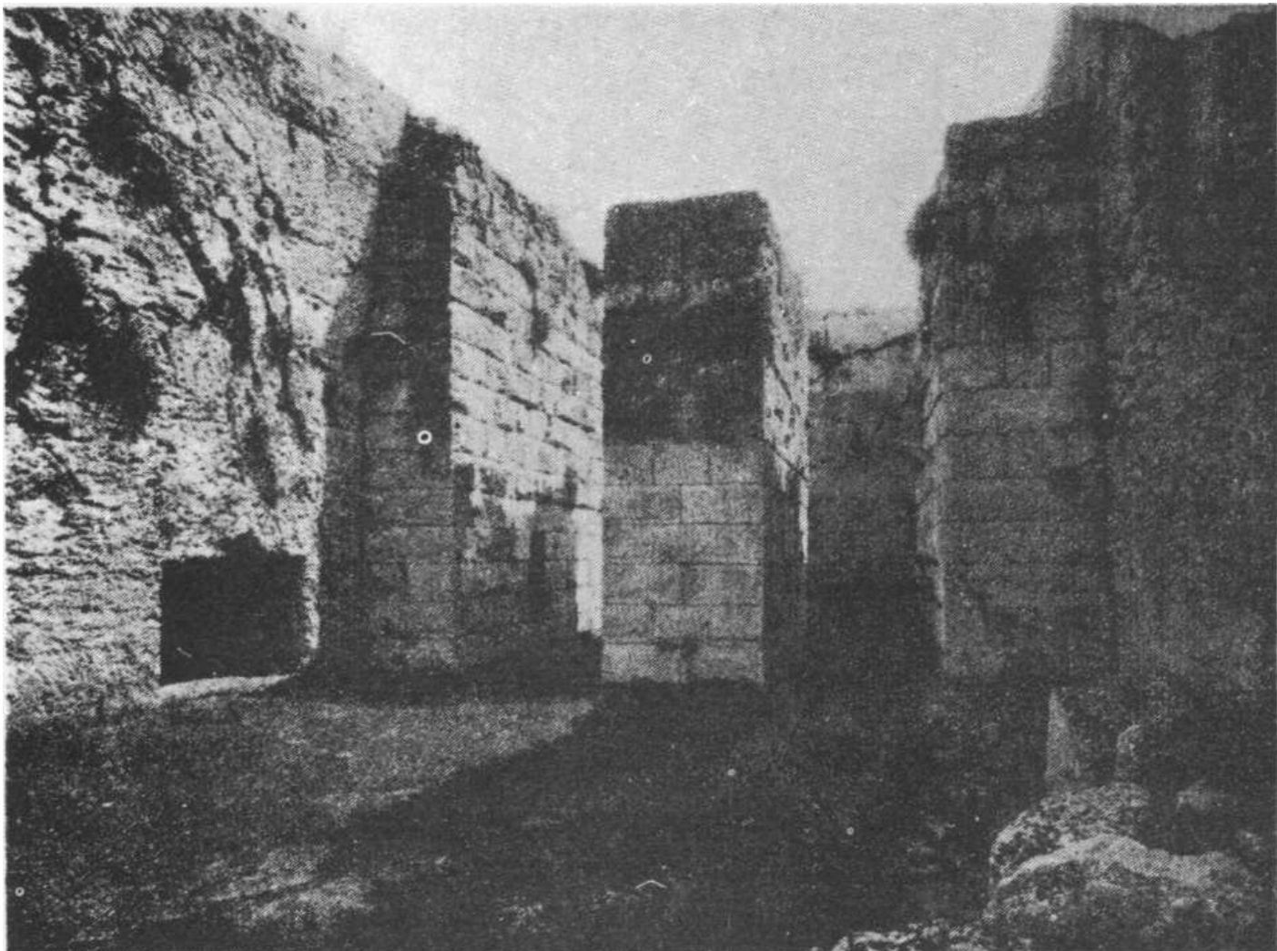
Fig. 4 - Piloni del ponte levatoio verso l'estremità del 3° fossato.
