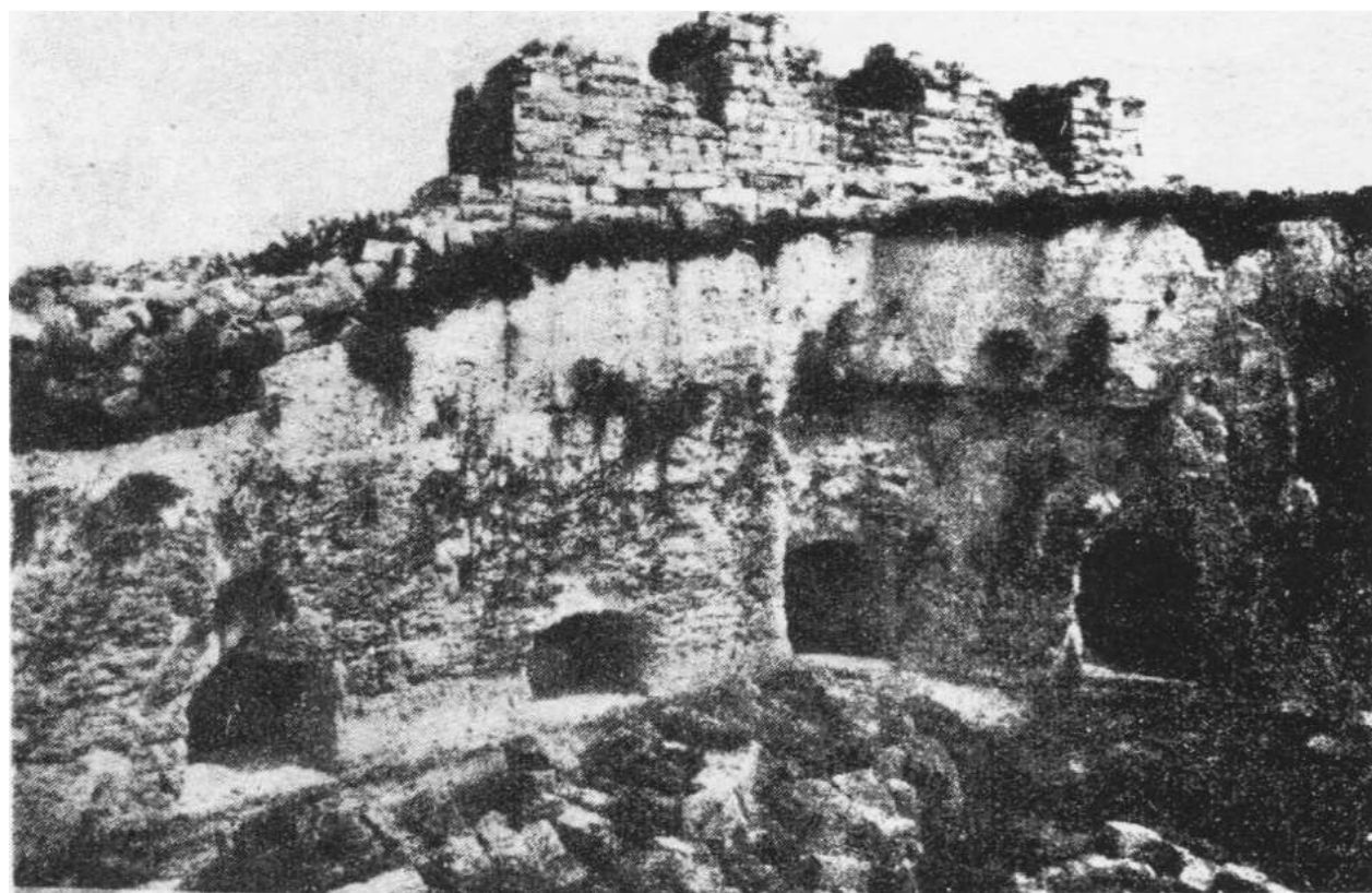
Fig. 1 - Avanzi delle grandi torri del mastio visti dalla estremità nord del 3° fossato.
