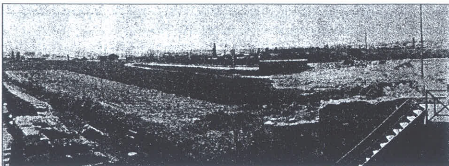
Fig. 4 - Siracusa, altare di Ierone II. Veduta dell'area a ovest prima dell'inizio degli scavi Gentili-Stucchi (da GENTILI, Siracusa - Ara di Gerone , cit., fig. 1).
