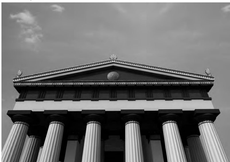
Particolare del frontone Est.
