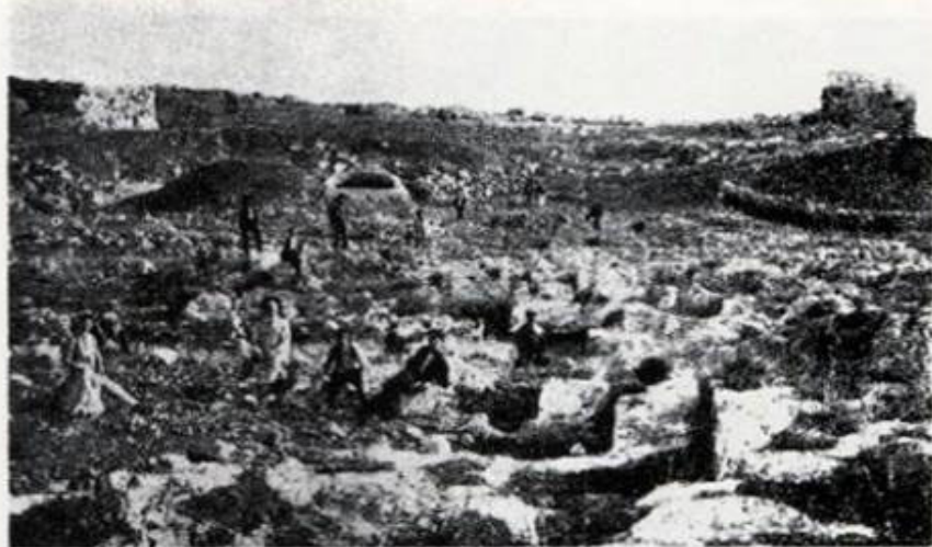
Fig. 13 - Veduta di tramontana delle rovine del mastio.
