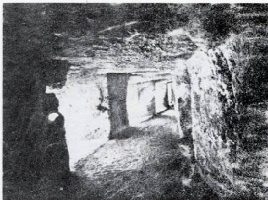
Fig. 15 - Galleria di comunicazione aperta nella roccia parallelamente al 3° fossato.
