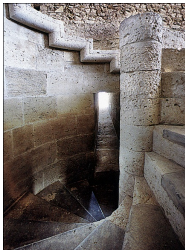
Scala torre Ovest; in evidenza il proseguimento della risega oltre l'arresto dei gradini, Castello Maniace.
