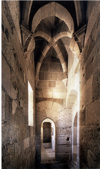
Vestibolo torre Sud, in fondo la stanzetta da bagno, Castello Maniace.
