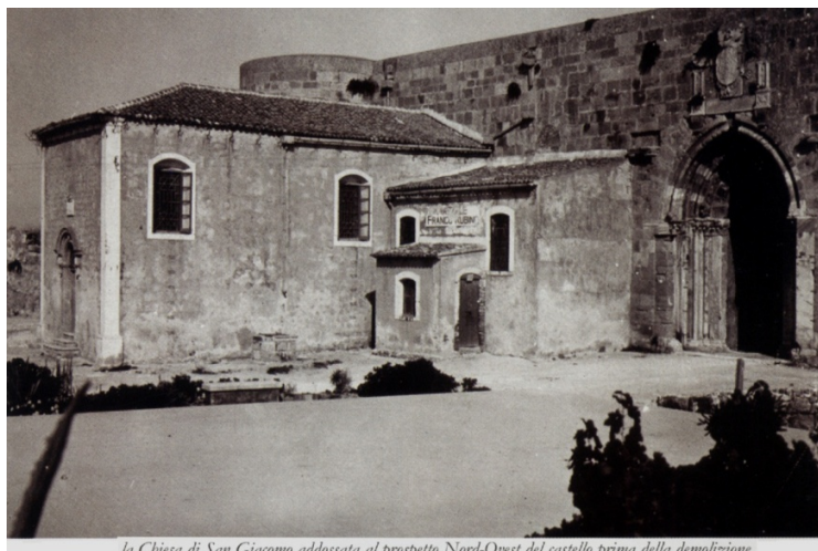
la Chiesa di San Giacomo addossata al prospetto Nord-Ovest del castello prima della demolizione.
