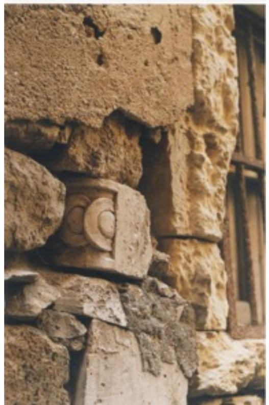
**Figura 27**, esempio di riuso dei materiali, in un edificio ricostruito dopo il terremoto.
