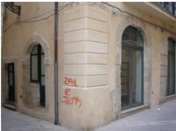
**Figura 41b**, un altro esempio di arco con banco inserito nella struttura dello stesso. Palazzetto molto rimaneggiato in Vicolo IV alla Giudecca.
