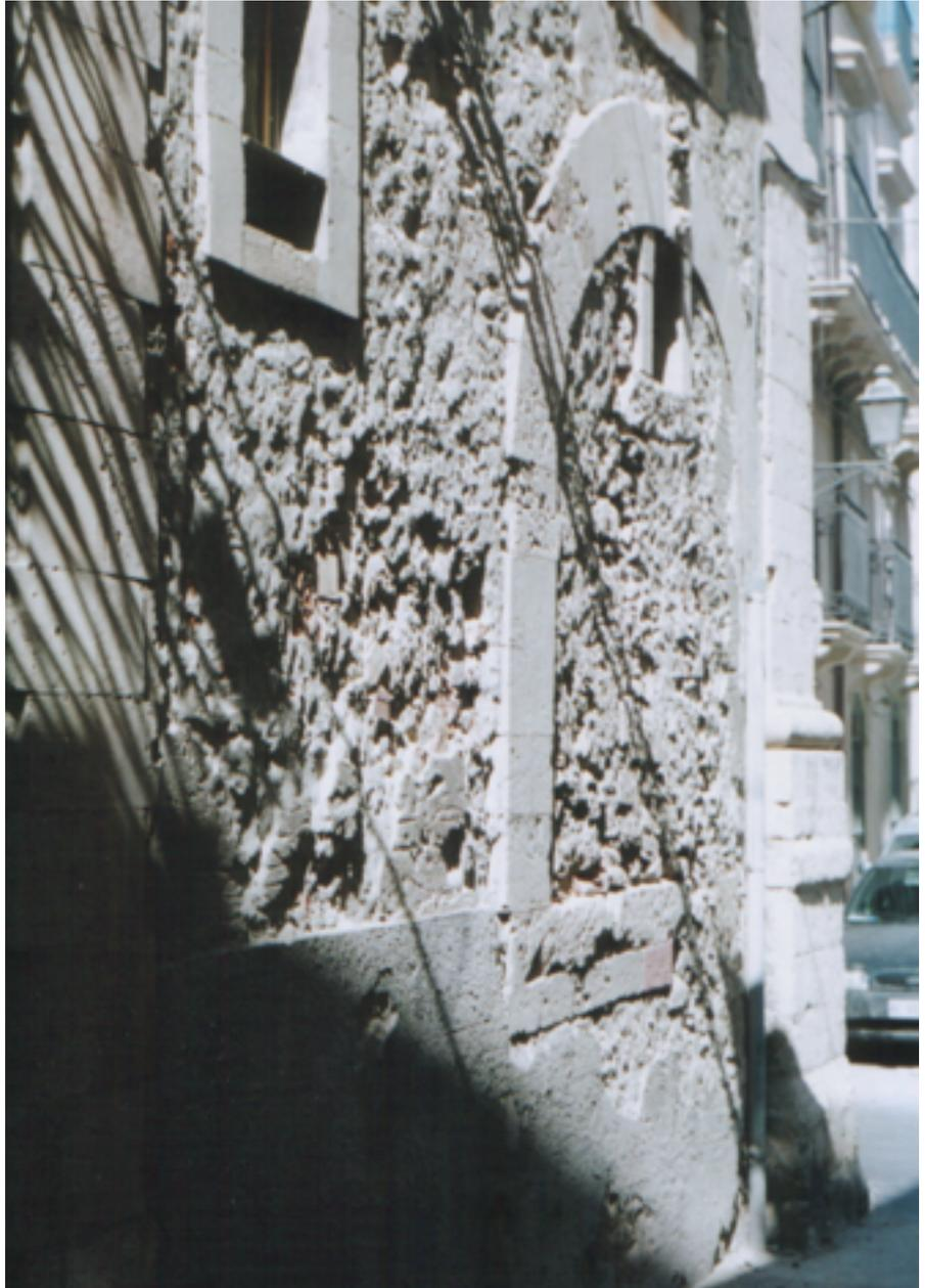
**Figura 41a**, Arco su via Capodieci, si noti il banco della spezieria inglobato nella muratura.
