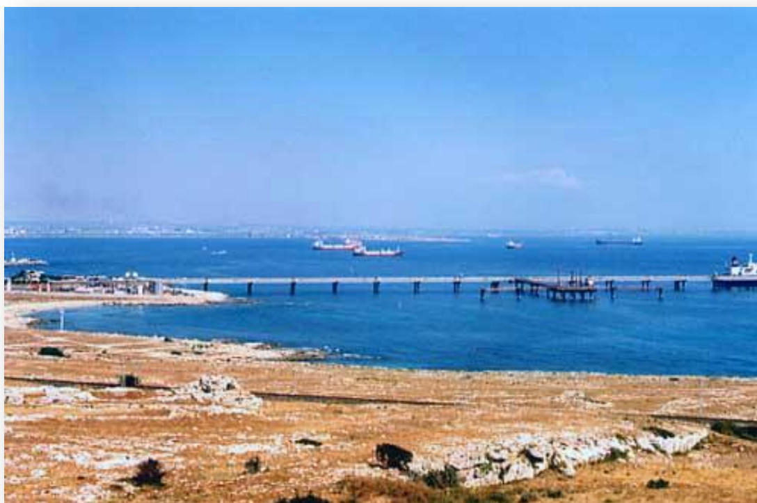
Fig. 1 - Il pontile ISAB/LUKOIL e la piccola insenatura di Stentinello.
