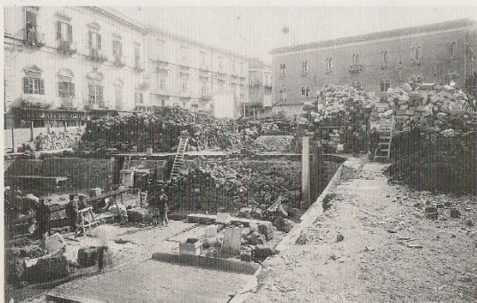
Vedute. Costruzione della nuova sede del Banco di Sicilia: lato sud (piazza Archimede).
