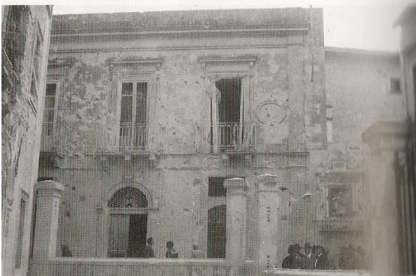
I danni. Via Gargallo: la facciata e la cancellata (divelta) del Liceo, civili abitazioni e l'edicola di san Gaetano.
