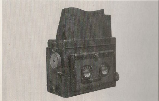
Apparecchio portatile Mentor stereoscopico reflex formato 6x13 cm con obiettivi Tessar F. 1:4.5 9 cm.
