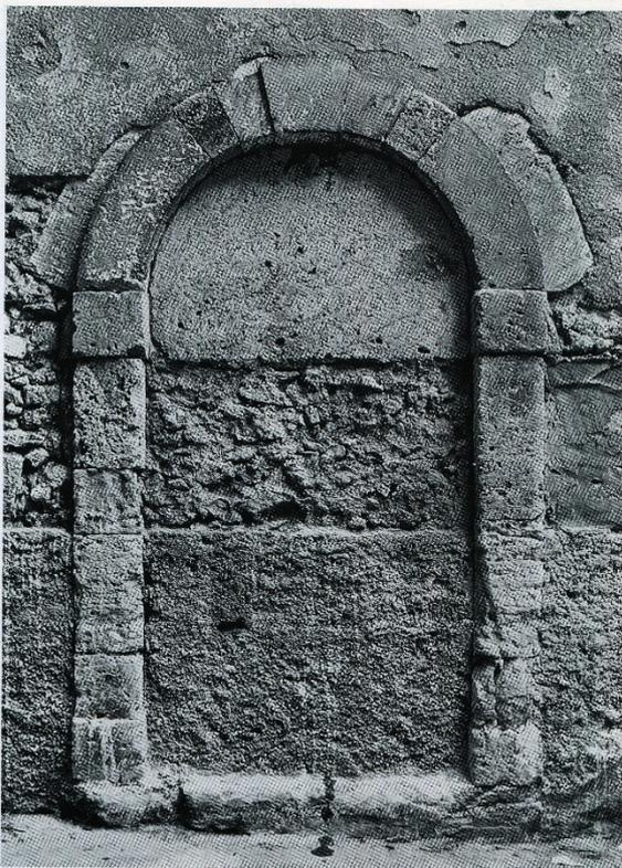
Fig. 8. Una porta tamponata: dove manca l'intonaco è visibile la stereometria dei conci. All'estradosso la centinatura è limitata alla parte in aggetto rispetto al filo dell'intonaco.
