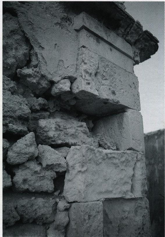
Fig. 13. Distacco di una lastra di cantonale.
