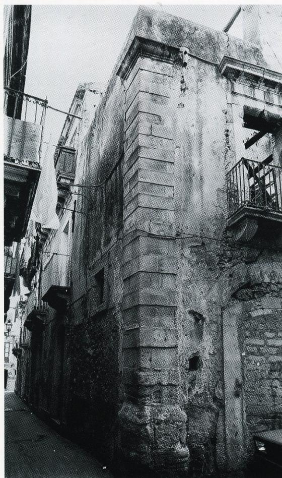
Fig. 11. Angolo tra via Dione e via delle Grazie: il cantonale in pietra da taglio definisce architettonicamente l'angolata della casa.
