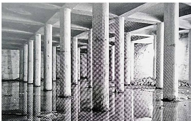
Figura 28 a-b: In alto casamatta (foto di S. Agnello) e sotto deposito di carburante (immagine tratta da Bovi – Moscuza, 2018)
