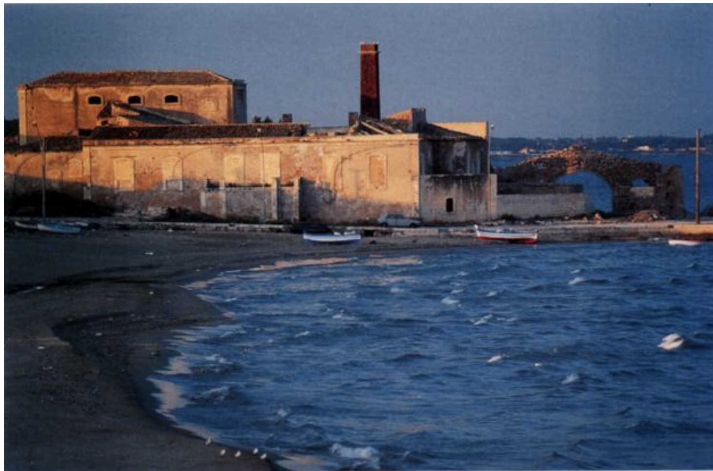
Avola (ex Fiume di Noto) - Il palazzetto del proprietario.
