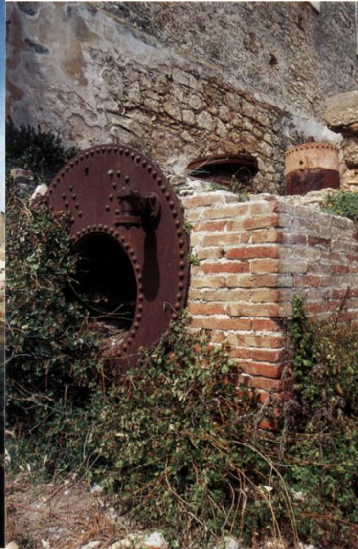
Avola (ex Fiume di Noto) - La caldaia.
